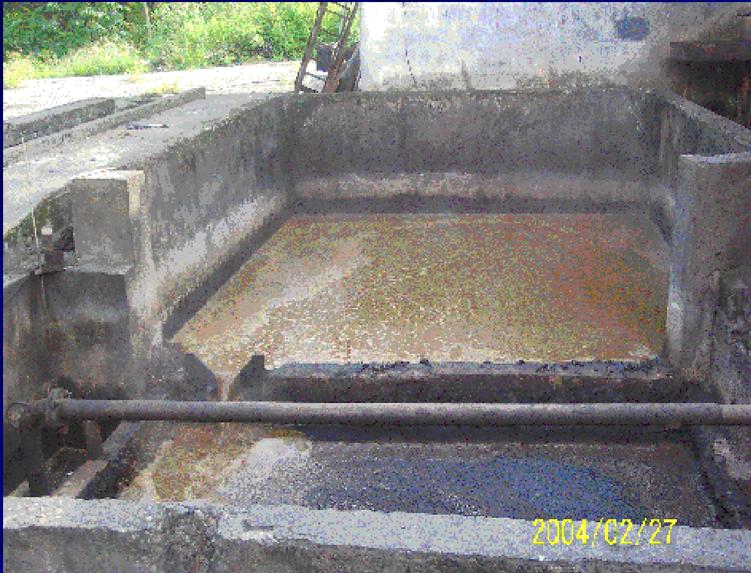
Tanque sedimentador y Vertedero en “V”
